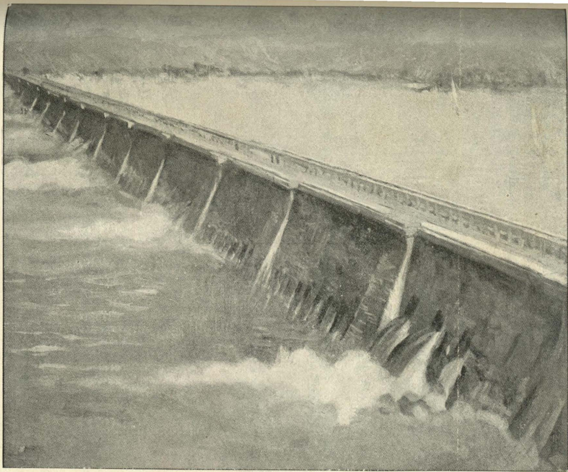
Fig. a LXXXII—Photogravura do desenho em perspectiva da barragem completa, com as dahabijés a velejarem sobre as antigas ilhas. (Vide Fig. a LXXIX). ROL. DE ARCHIT. E ARCHEOL., T. XI, N. o 9—PAG. 537
